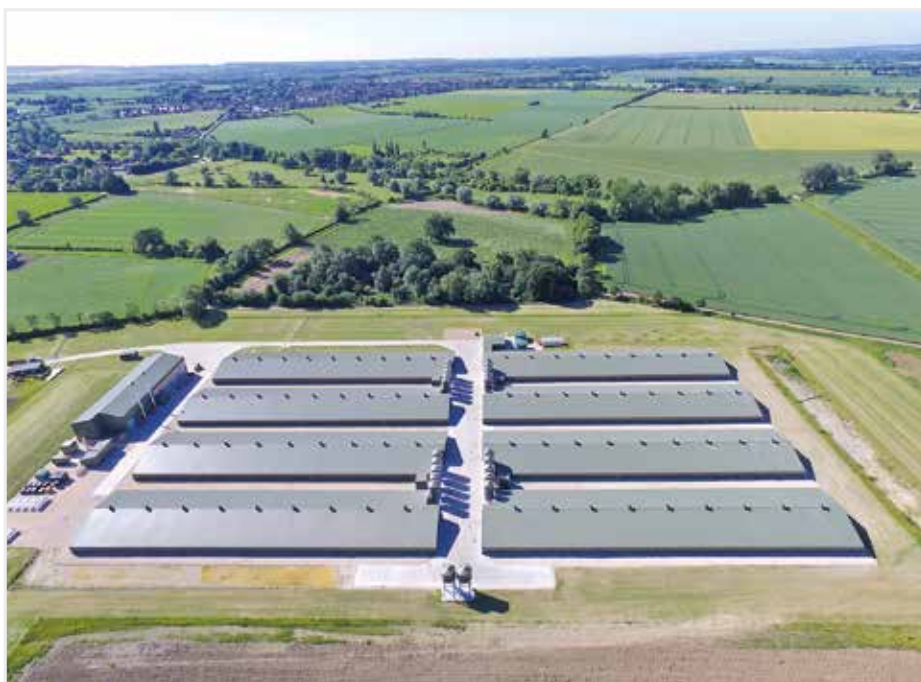
De 8 stallen (91 x 21 m) zijn mooi ingepland en links is de houtverbrandingsinstallatie te zien.
