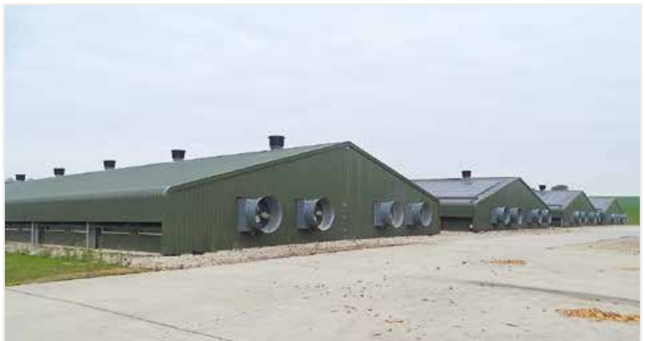
De stallen zijn langs de buitenzijde in egale donkergroene kleur afgewerkt. Naast de 8 nokventilatoren zijn er 4 Blue Fan ventilatoren in de kopgevel geïnstalleerd.
