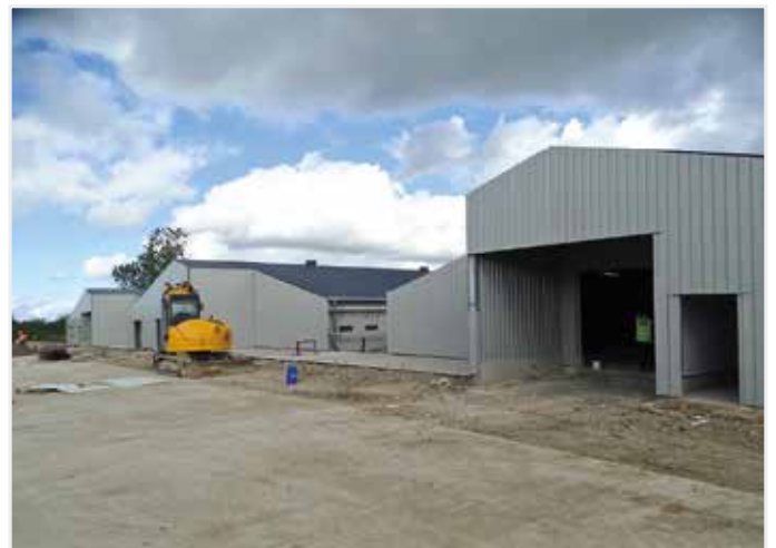
De nieuwe stallen in opbouw. Muren en daken zijn geprofileerde dunne platen waartussen respectievelijk 14 en 24 cm rockwool aangebracht is.
