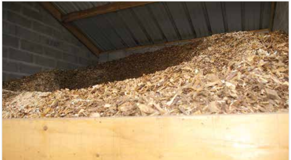
De stal die we bezochten haalt zijn energie uit een biomassa installatie. De bunker van 40 kubieke meter zorgt via een vijzel voor regelmatige aanvoer.
