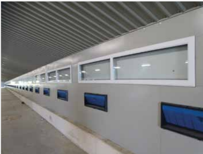
Binnenzicht in de nieuwe stallen. Merk de vensters die slechts indirect diffuus licht toelaten. De koeling moet nog geïnstalleerd worden.
