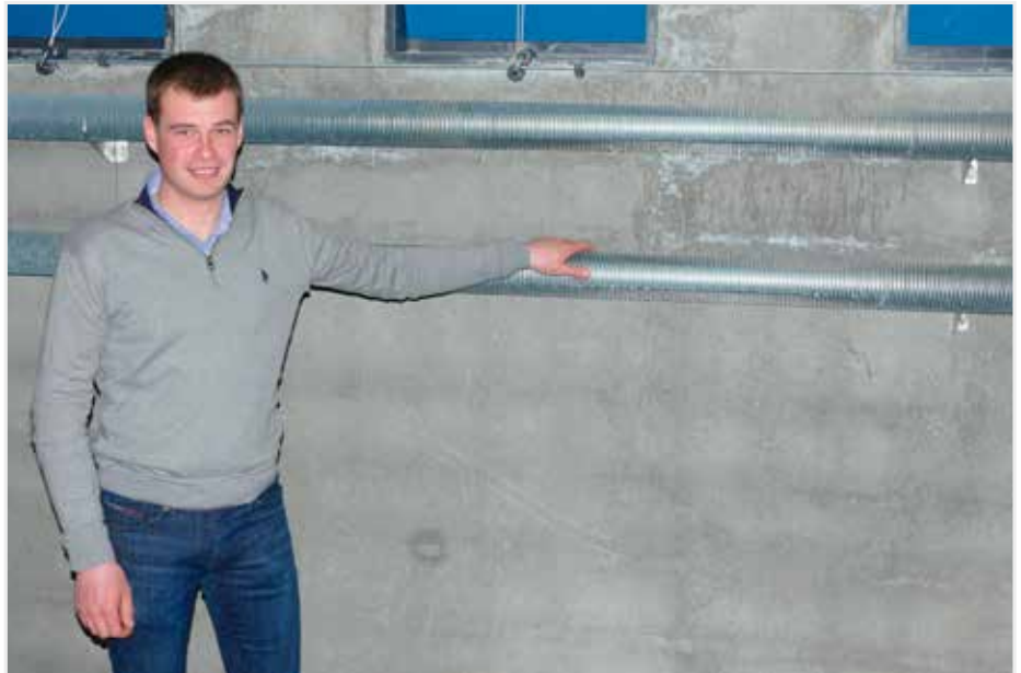
De jonge bedrijfsleider Giles Van Vynckt, die gekozen heeft voor het Spiraflex buizenverwarmingssysteem o.a. omwille van de eenvoud en energiebesparing.
