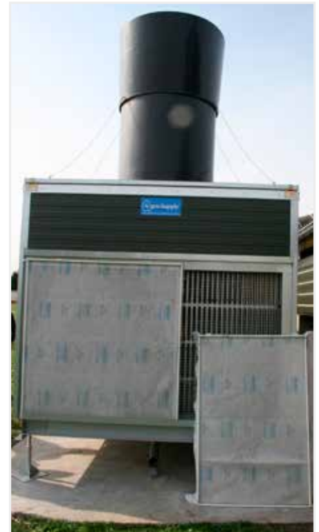
Een regelmatige reiniging van de lamellen van de warmtewisselaar is noodzakelijk om het rendement op peil te houden.
