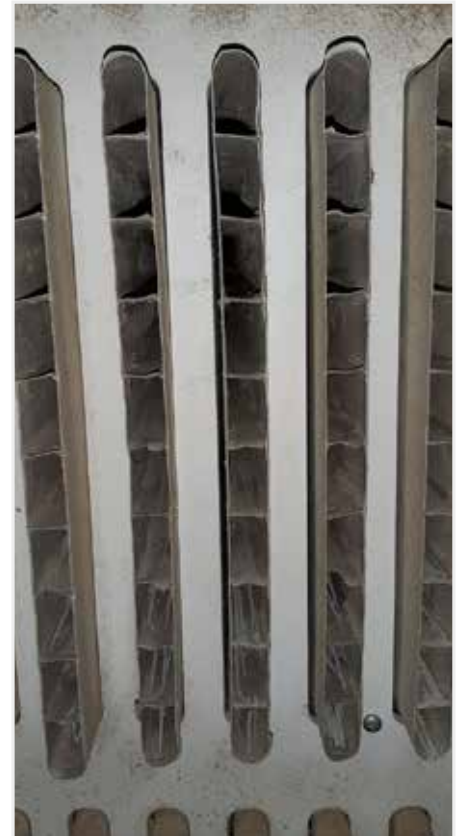
Sterk vervuilde lamellen (links) doen de capaciteit van een warmtewisselaar sterk dalen. Rechts de lamellen na reiniging met perslucht.
