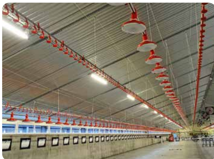
Het plafond is mooi afgewerkt met aluminium geprofileerde platen. Bemerkt verder de Réwenta voerpannen en de lichtstraat over de ganse lengte.
