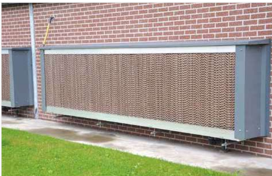
Pad koeling wordt in zuiderse landen frequent toegepast maar is in onze contreien een dure investering.
