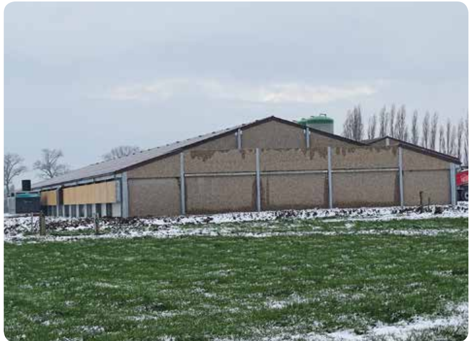
De stal is aan de zijkanten afgewerkt met houten panelen voor de luchtinlaten en heeft een aangebouwde stofbak.
