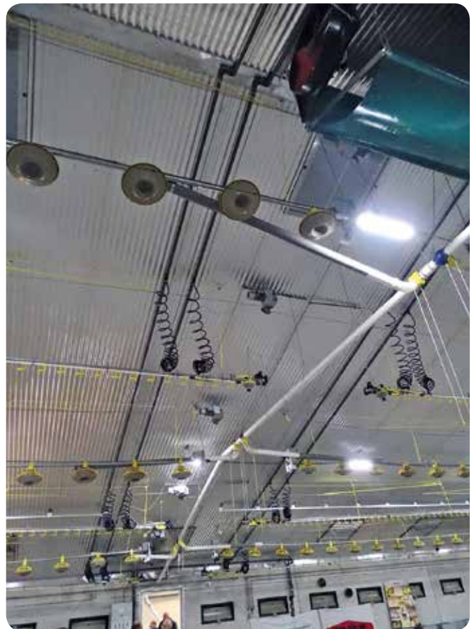
Midden in 105m de lange stal zijn alle lijnen opgedeeld en zijn de voederhoppers geplaatst.
