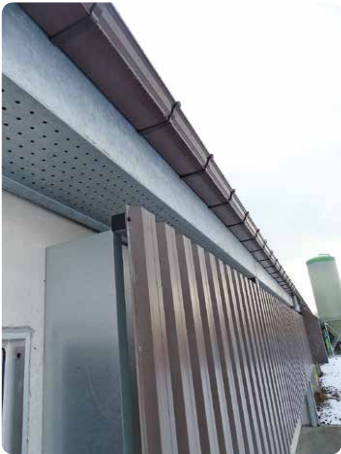
De in één stuk gegoten, geperforeerde en gegalvaniseerde S-vormige dakoversteek zorgt voor een mooie aansluiting van zowel de zijmuur, de gordingen als de golfplaten.
