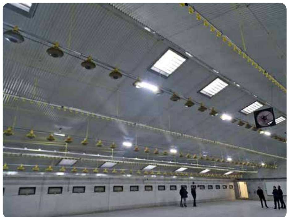
De 6 voederlijnen en 5 drinknippellijnen kunnen automatisch opgelieerd worden. Drie rijen, verduisterbare dakvensters zorgen voor veel natuurlijke lichtinval.
