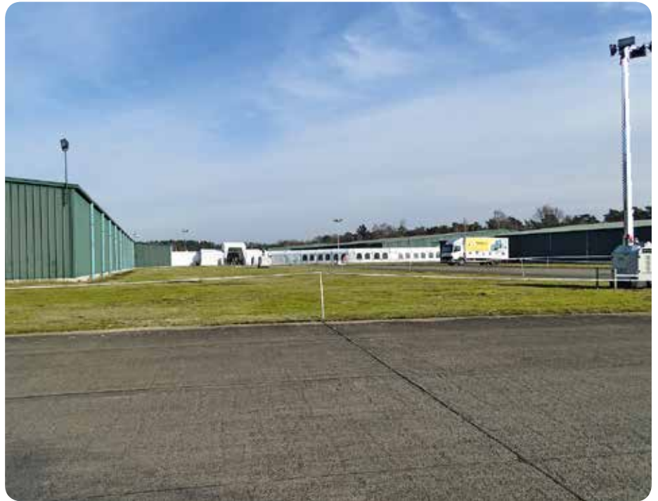
Door overdekte sassen worden de hallen comfortabel met elkaar verbonden.
